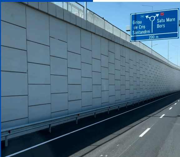
PANOURI PĂMÂNT ARMAT Centura Oradea legătură Autostrada A3 Biharia- STRABAG
