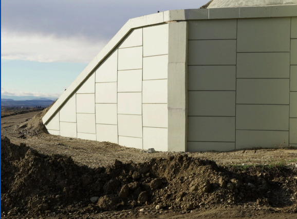
PANOURI PĂMÂNT ARMAT Lot 1 Târgu Mureş-Ungheni şi drum de legătură Autostrada A3 STRABAG-GEIGER-NOVATEX
